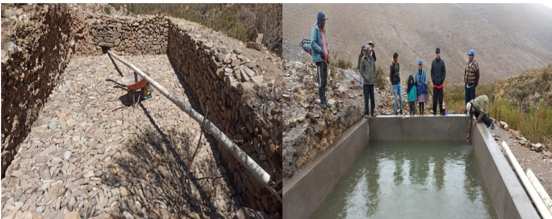
Construcción de estanque y mejora de sistemas de riego
