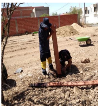
Posteado para el cerramiento perimetral
