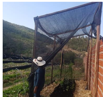
Armado de la estructura del vivero con protección de malla semisombra
