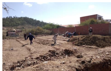
Remoción del suelo con maquinaria para nivelación y extracción
