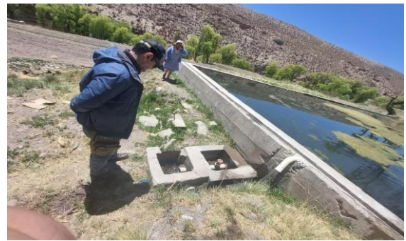
Estanque refaccionado funcionando al 100% de su capacidad
