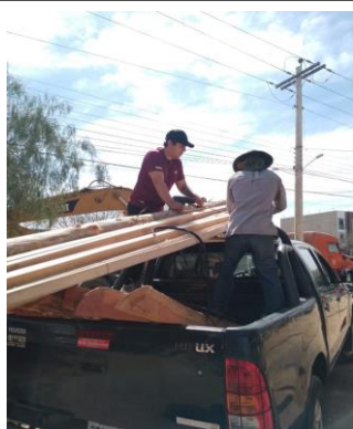
Materiales para la construcción del vivero
