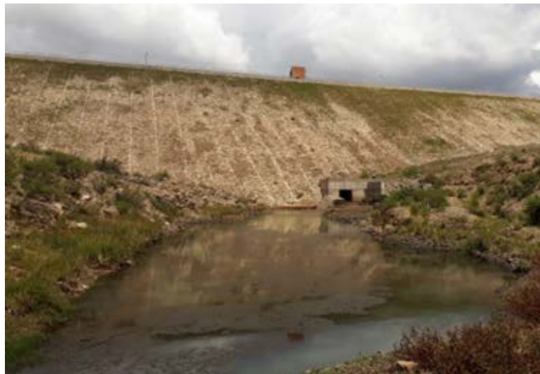
Foto: SEDEGIA, año 2020 (Presa Huacata)
