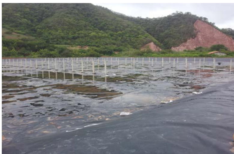
Imágenes de la Ptar – Entre Ríos
