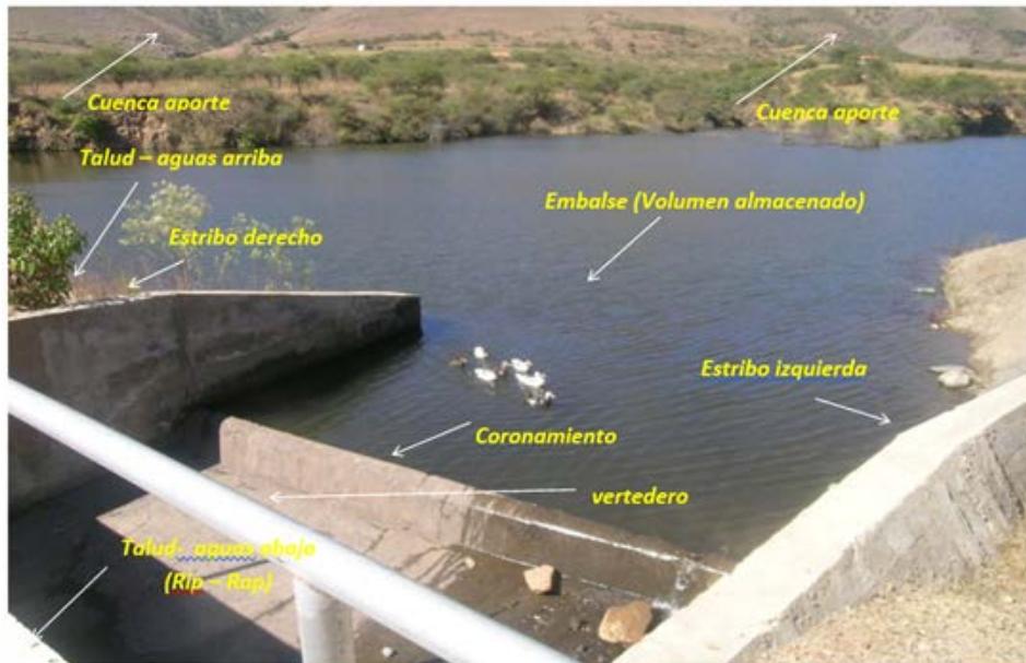
Figura N° 1 Componentes de una Presa
